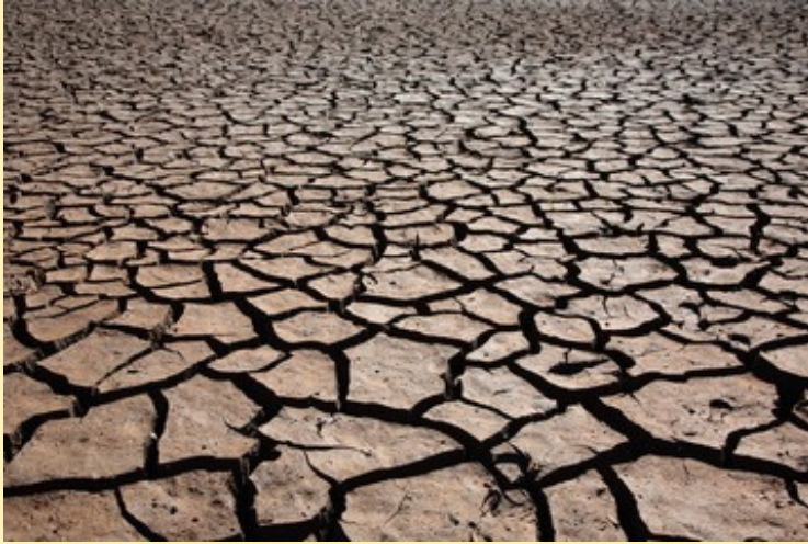
DESECACIÓN ( grietas de retracción )
